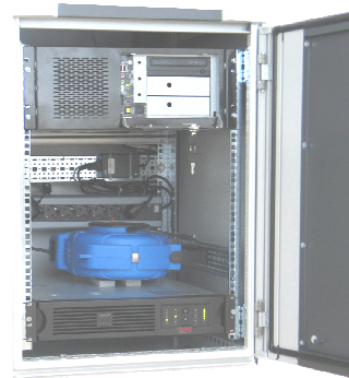
Wartungsfreundlicher 19"-Einbau des Servers
